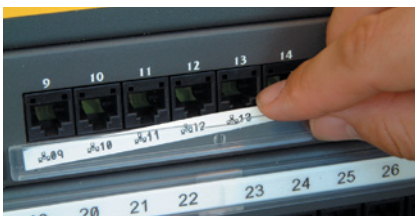
Etiketten für Klemmblöcke und Patch Panels
